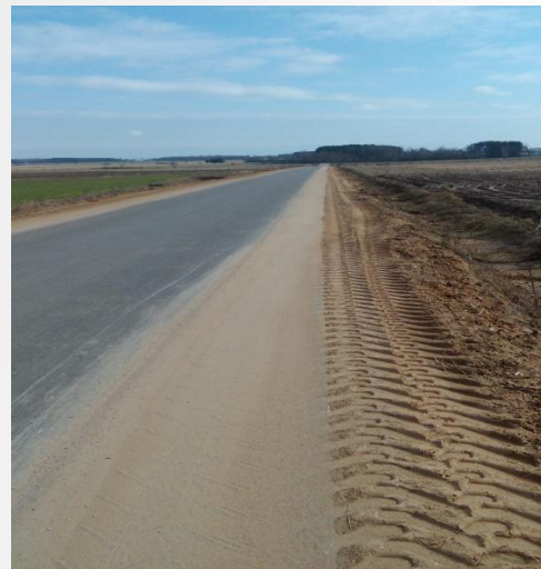
Zdjęcie – wyremontowana droga o nr geod. 359 obręb Domanowo
