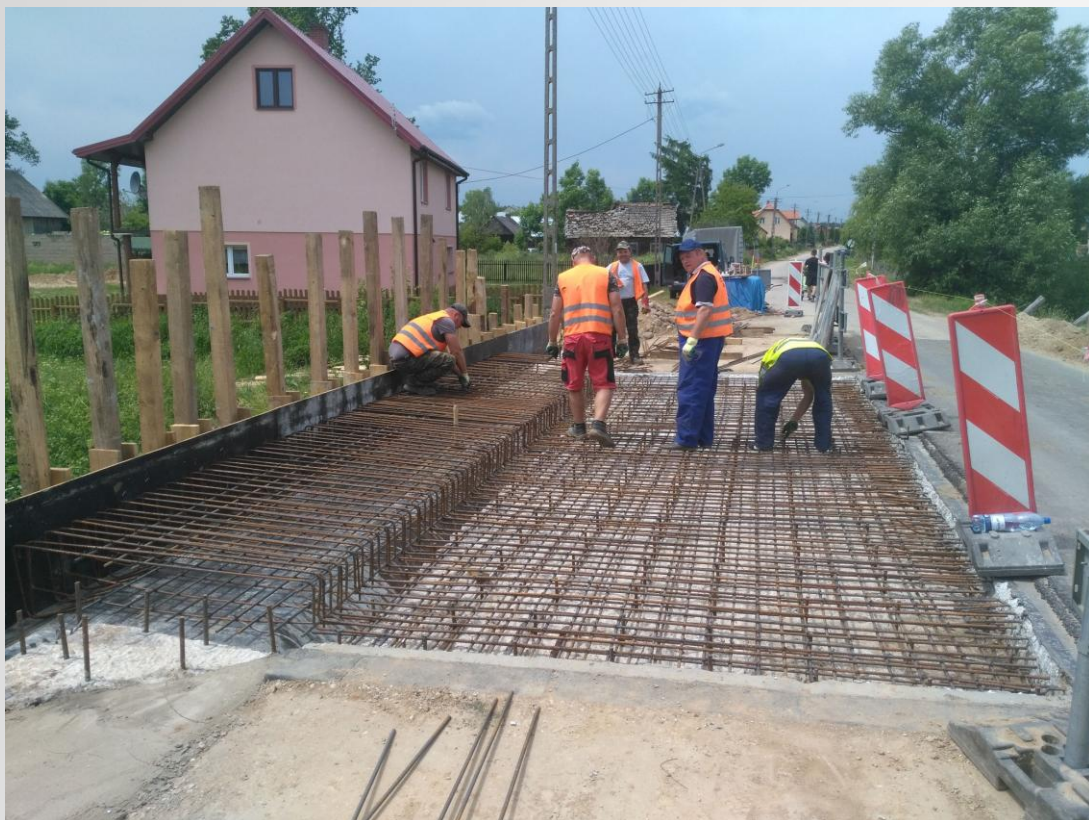
Remont mostu w miejscowości Świrydy
