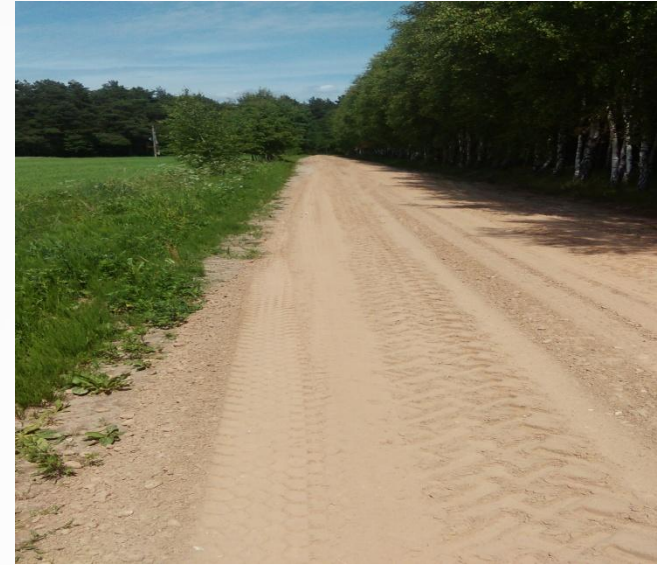
Zdjęcia - droga gminna tzw. dojazdową do kolonii położoną w obrębie gruntów wsi Widźgowo na którą nawieziono kruszywo łamane.
