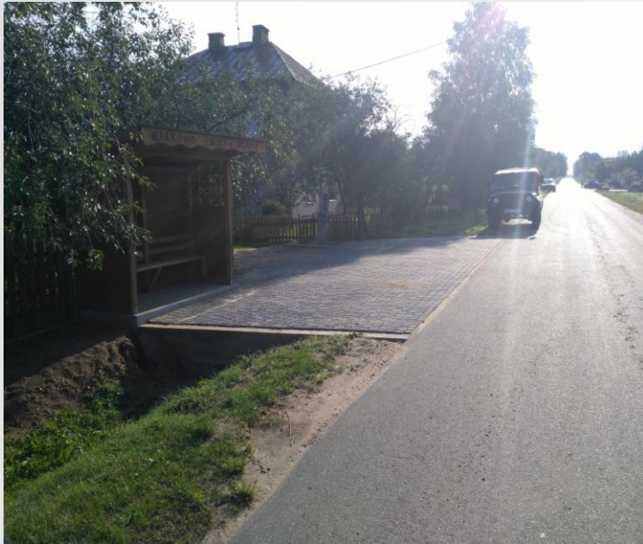
Sołectwo Pasieka – ułożono wjazdy na posesję z kostki brukowej.
