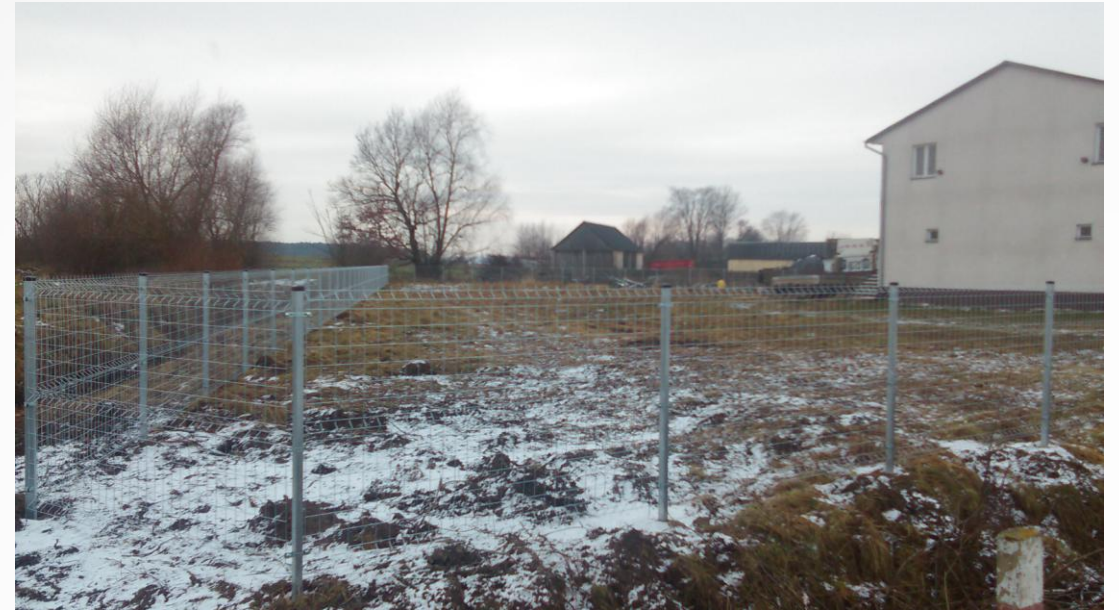
Plac przy remizie w Chojewie - wykonano ogrodzenie panelowe.
