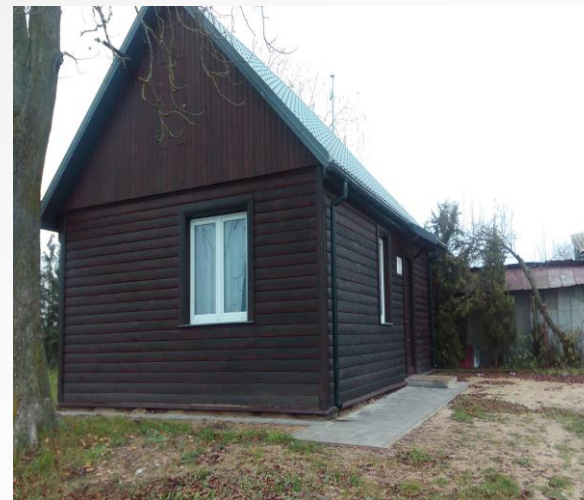
Świetlica Poletyły - wymieniono pokrycie dachowe oraz ułożono chodnik do budynku.
