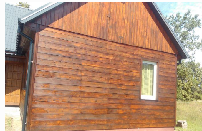
Świetlica Załuskie Kościelne - wymieniono pokrycie dachowe oraz odnowiono elewację budynku.
