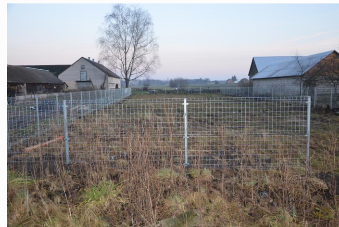
Wieś Kiersnowo – wykonano ogrodzenie panelowe działki 298/2.
