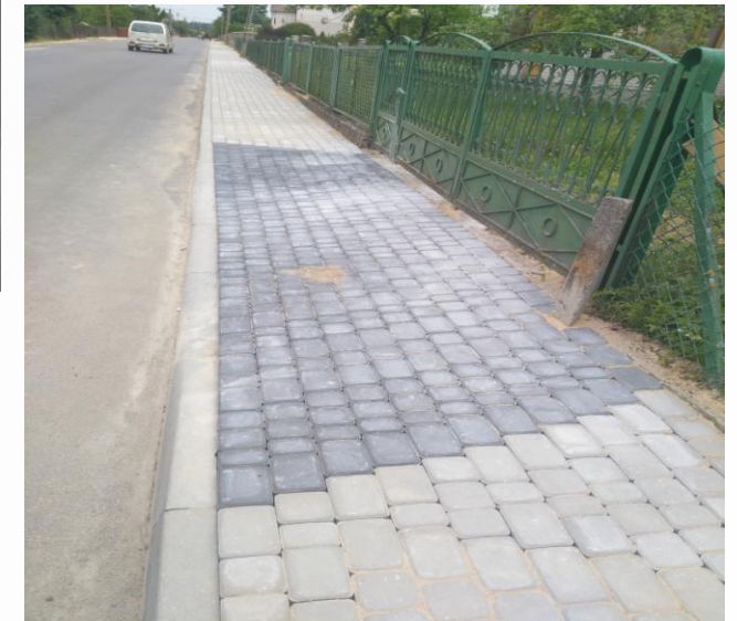
Wieś Lubieszce – wykonano chodnik oraz zjazd z kostki betonowej.
