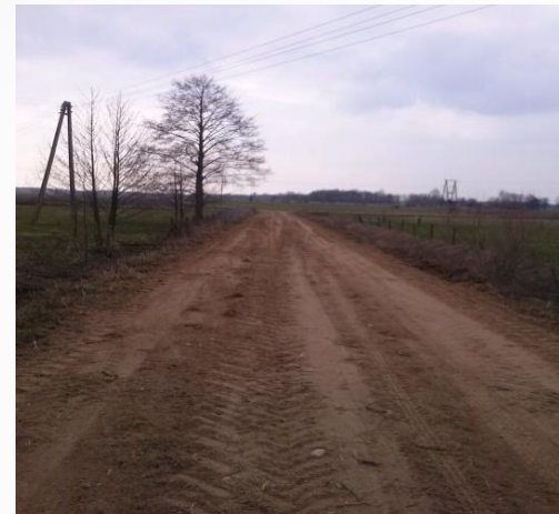
Zdjęcie – wyremontowana droga o nr geod. 499 obręb Domanowo
