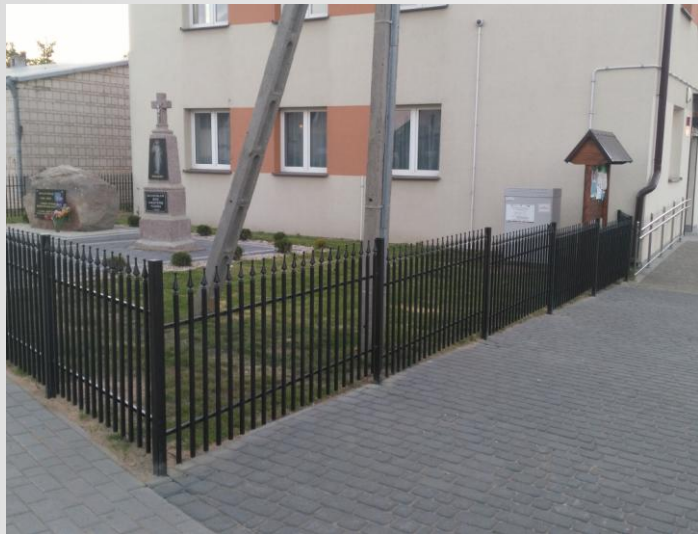
Remiza Popławy – wykonano ogrodzenie.
