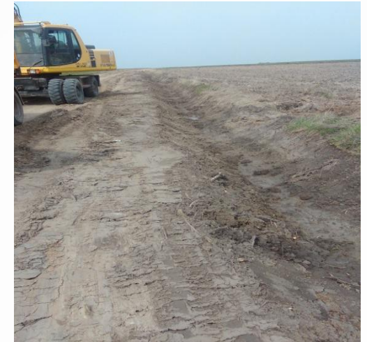
Zdjęcie – wyremontowana droga o nr geod. 204 obręb Domanowo
