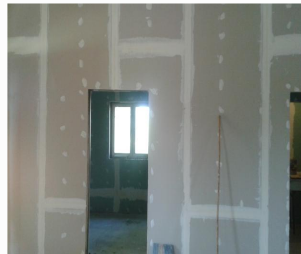
Świetlica Puchały Nowe - wykonano remont pomieszczeń.
