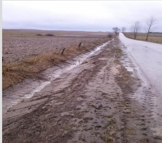
Zdjęcie – wyremontowana droga o nr geod. 359 obręb Domanowo
