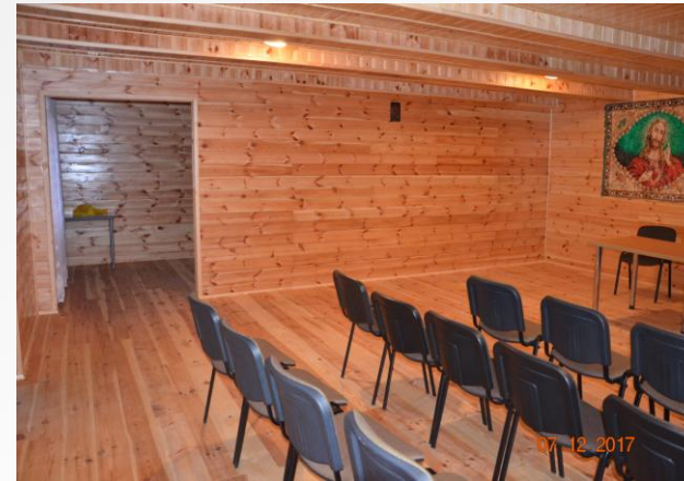
Świetlica Kadlubówka – ułożono i pomalowano szalówkę na ścianach.
