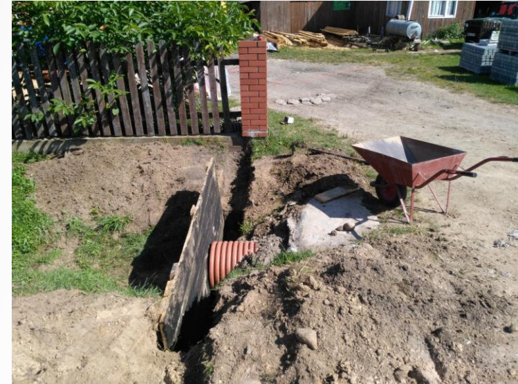
Sołectwo Pasieka - zamontowano rury przepustowe wykorzystane do naprawy wjazdów.
