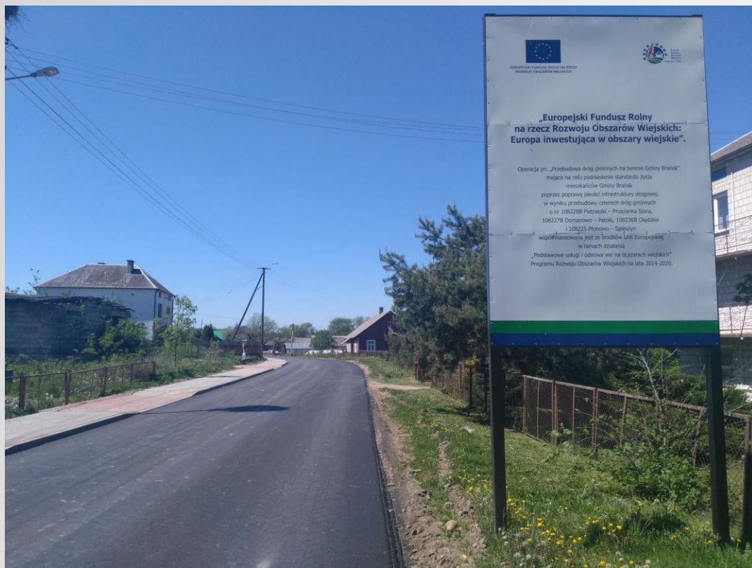
Przebudowana droga gminna Nr 108236B w miejscowości Olędzkie
