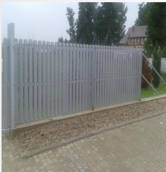
Wieś Mień – ułożono parking z kostki betonowej oraz wykonano nową bramę.
