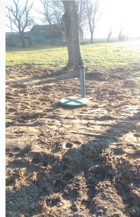
Świetlica Brzeźnica - zamontowano zbiornik bezodpływowy przy budynku.
