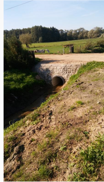
Wieś Olędzkie – wyremontowano przepusty drogowe szt. 2.
