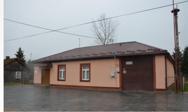
Remiza Mień – utwardzono plac przed budynkiem.
