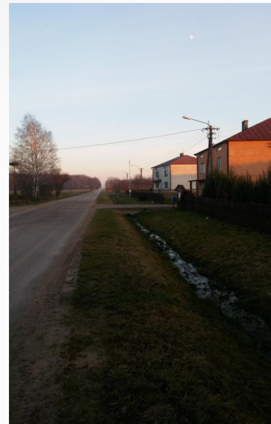
Sołectwo Pasieka – wykonano oświetlenie uliczne.
