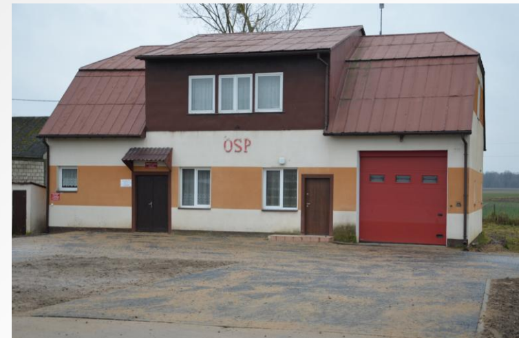
Remiza Lubieszcze – ułożono kostkę brukową na placu przed budynkiem.
