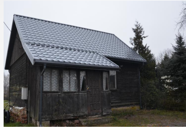
Świetlica Dębowa – wymieniono pokrycie dachowe.
