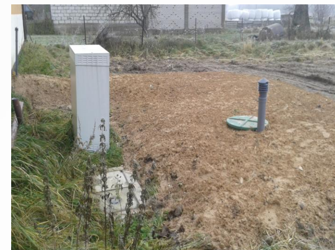
Remiza Lubieszcze - zamontowano zbiornik bezodpływowy przy budynku.
