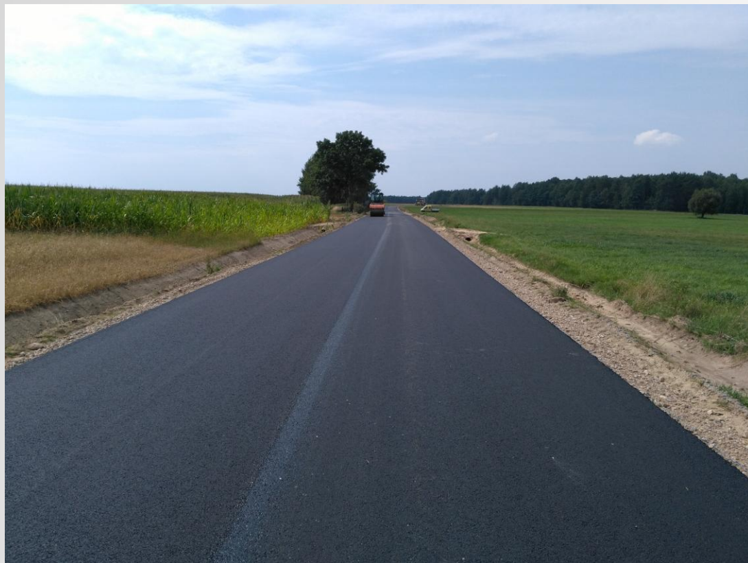
Przebudowana droga gminna Nr 108228B Pietraszki-Pruszancka Stara
