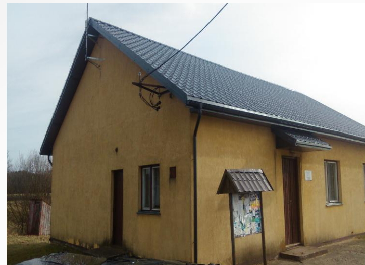
Świetlica Puchały Nowe - wymieniono pokrycie dachowe.
