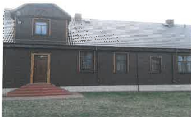
Balustrady i obróbki okien, drzwi wykonane i zamontowane w GOUK Kalnica
